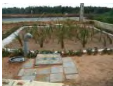
Instalación en EE.SS. BP, Almensilla (Sevilla) Primer sistema de evapotranspiración realizado en España.
